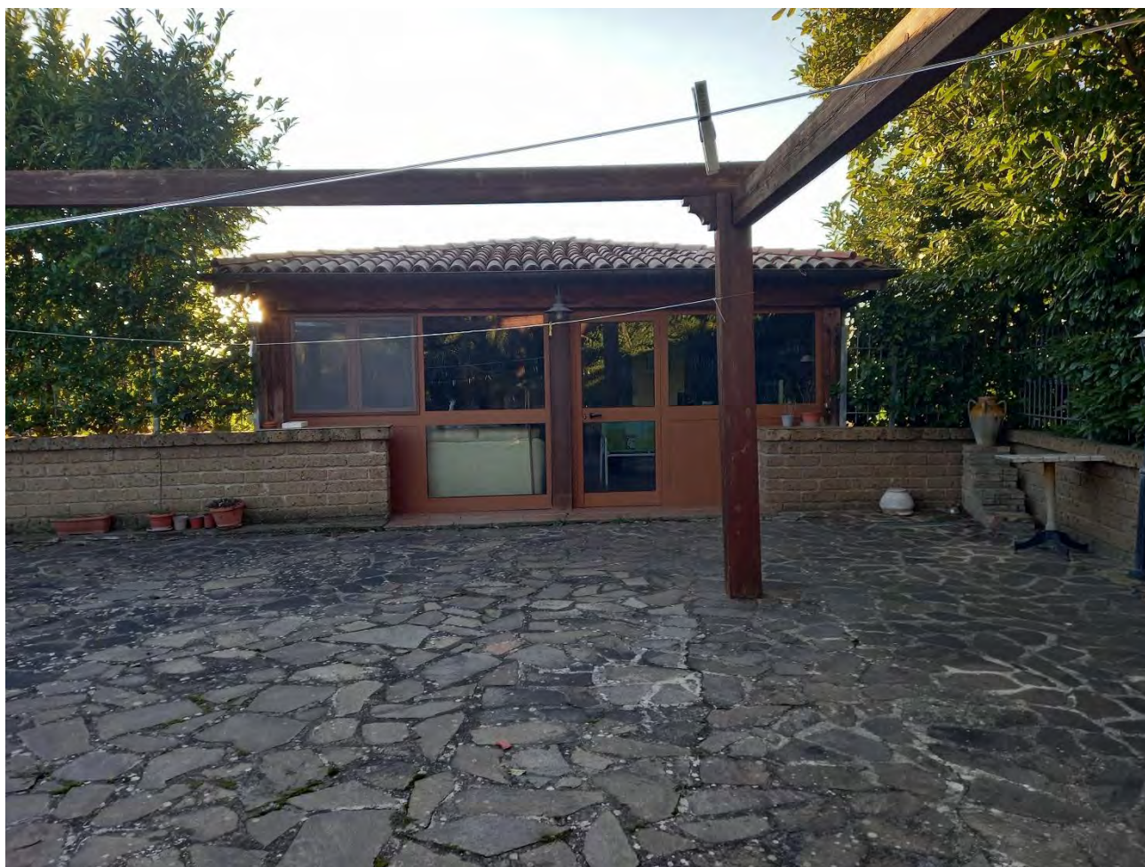
FOTO N. 13 – PROSPETTO EST DEL LOCALETTO PERTINENZIALE - U.I.U. SUB. 8
