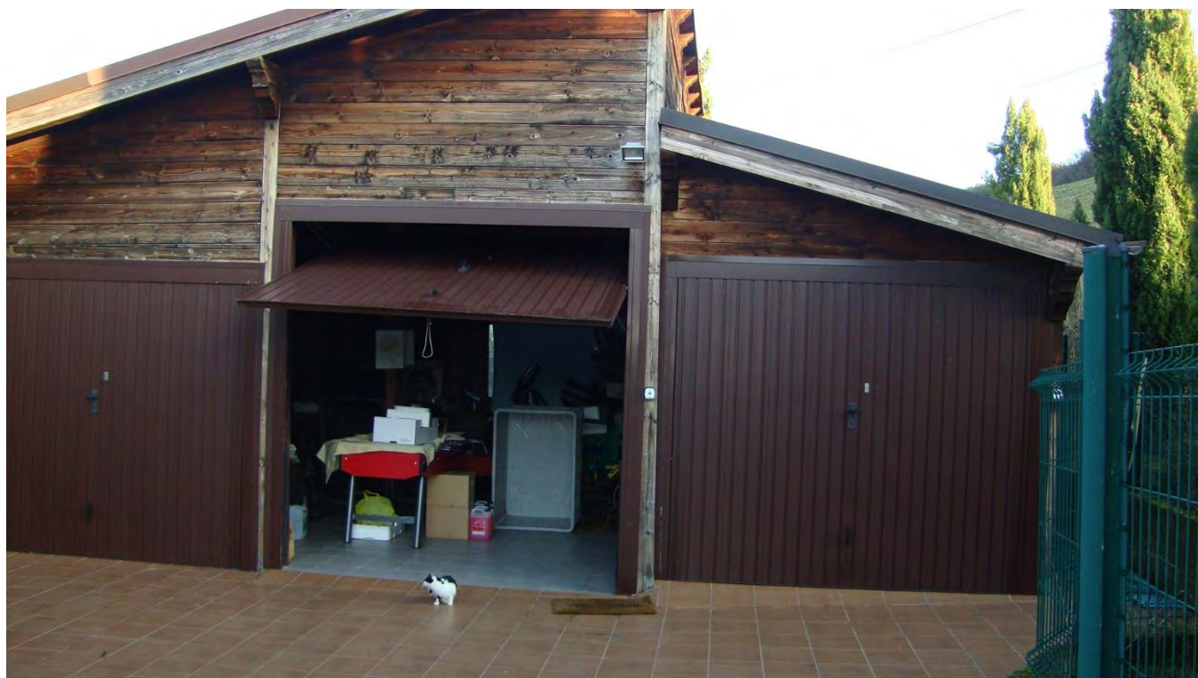
FOTO N. 14 – PROSPETTO OVEST DEL LOCALE AUTORIMESSE - U.I.U. SUB. 6
