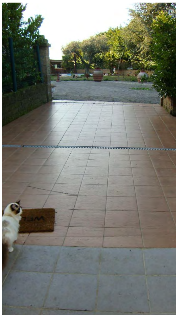
FOTO N. 32 – PIAZZALE ESTERNO AL LOCALE AUTORIMESSE - U.I.U. SUB. 6
