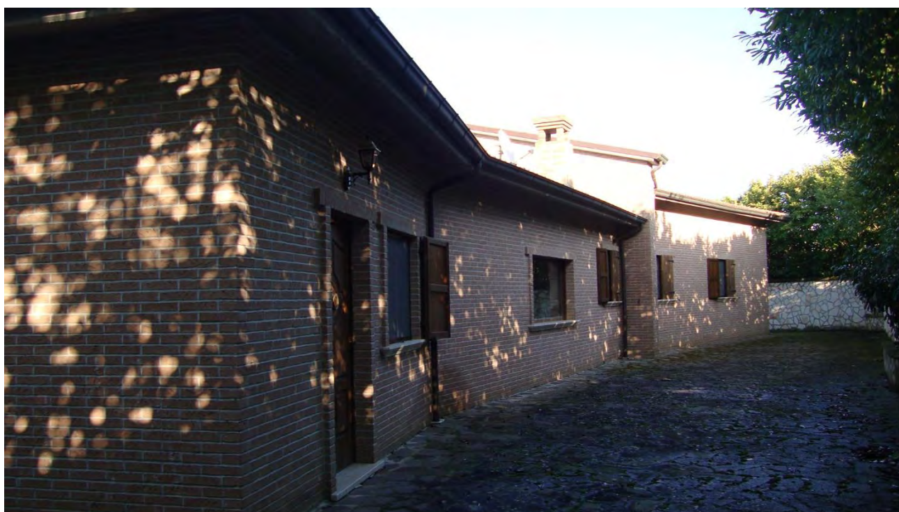
FOTO N. 12 –PROSPETTO NORD DEL FABBRICATO U.I.U. SUB. 3 e 8
