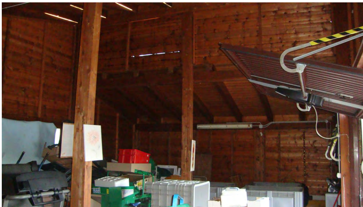
FOTO N. 31 – LOCALE AUTORIMESSE - U.I.U. SUB. 6
