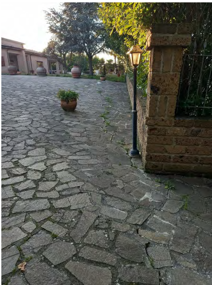
FOTO N. 5 – PAVIMENTAZIONE ESTERNA AL FABBRICATO NELL'AREA RECINTATA
